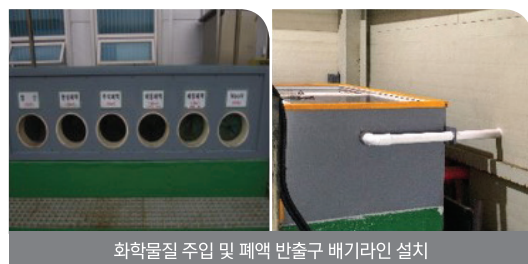
화학물질 주입 및 폐액 반출구 배기라인 설치
