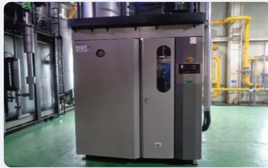
초 저Nox 보일러 추가 설치
